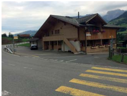
Abb. 2 erhaltenswertes Gebäude auf Parzelle Nr. 1521 mit Verkehrsfläche im Vorland bei der Einmündung Eystrasse in die Hauptstrasse
