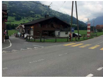
Abb. 3 erhaltenswerte Gebäude auf den Parzellen Nrn. 298 / 1052 im Bereich Ausbau der Einmündung Eystrasse in die Hauptstrasse auf Wiesland
